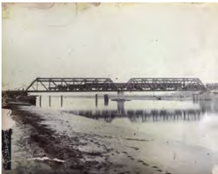
图4 《苏省铁路》相册 斜塘桥
